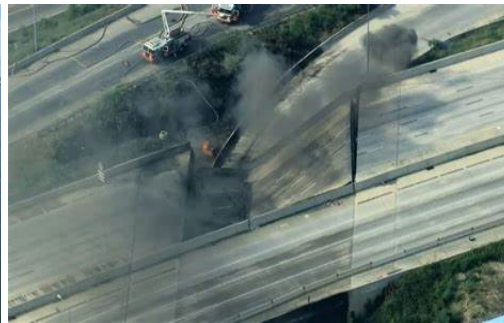
(d) Interstate 95 Collapse
